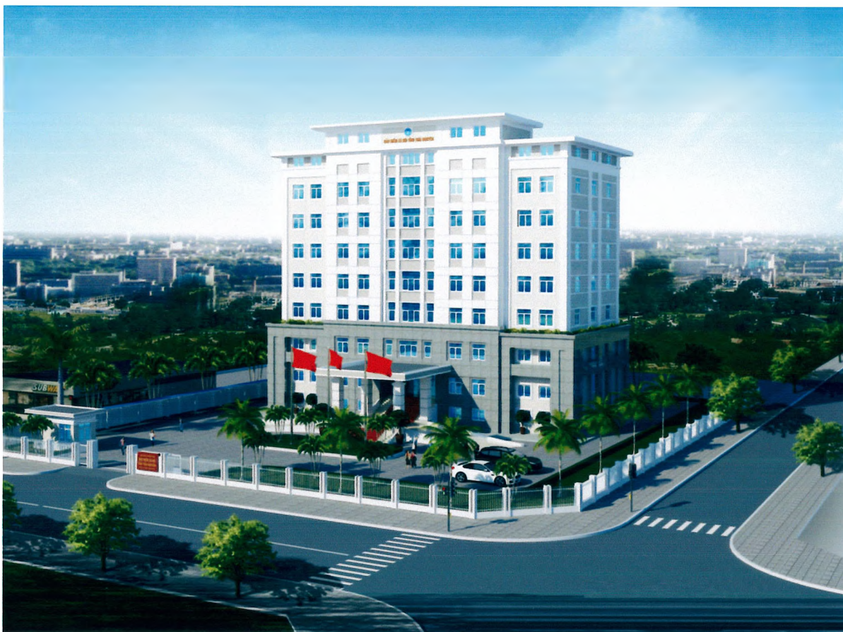
Dự án Trụ sở Bảo hiểm xã hội Tỉnh Thái Nguyên - Công ty cổ phần Đầu tư và xây lắp Thành An 665 thực hiện thi công
