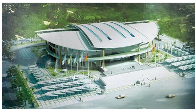
Thi công Nhà hát và triển lãm văn hóa nghệ thuật Bình Thuận
