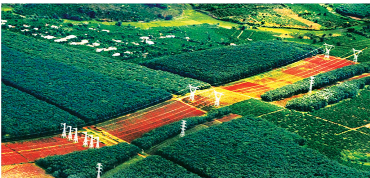
Đường dây 500kV Sơn La – Hòa Bình – Nho Quan
