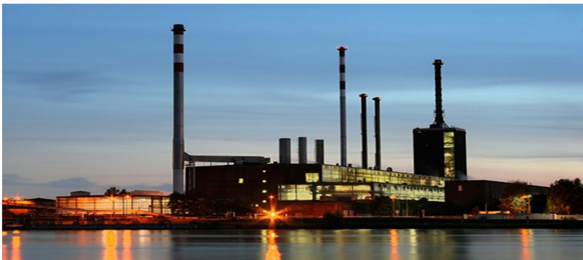
Nhà máy nhiệt điện Thái Bình 2
