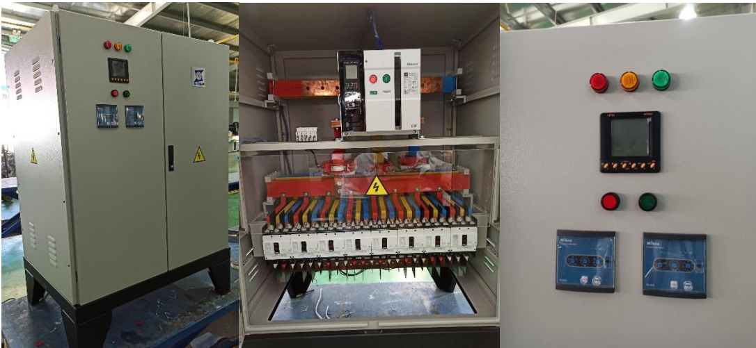
Tủ điện ACB của SAMETEL cho hệ Điện mặt trời
