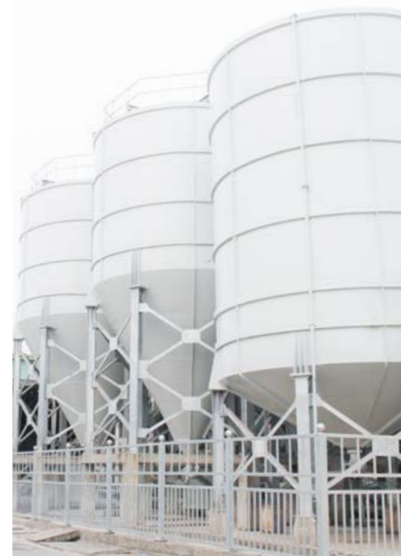
Hệ thống Silo nước tuần hoàn
