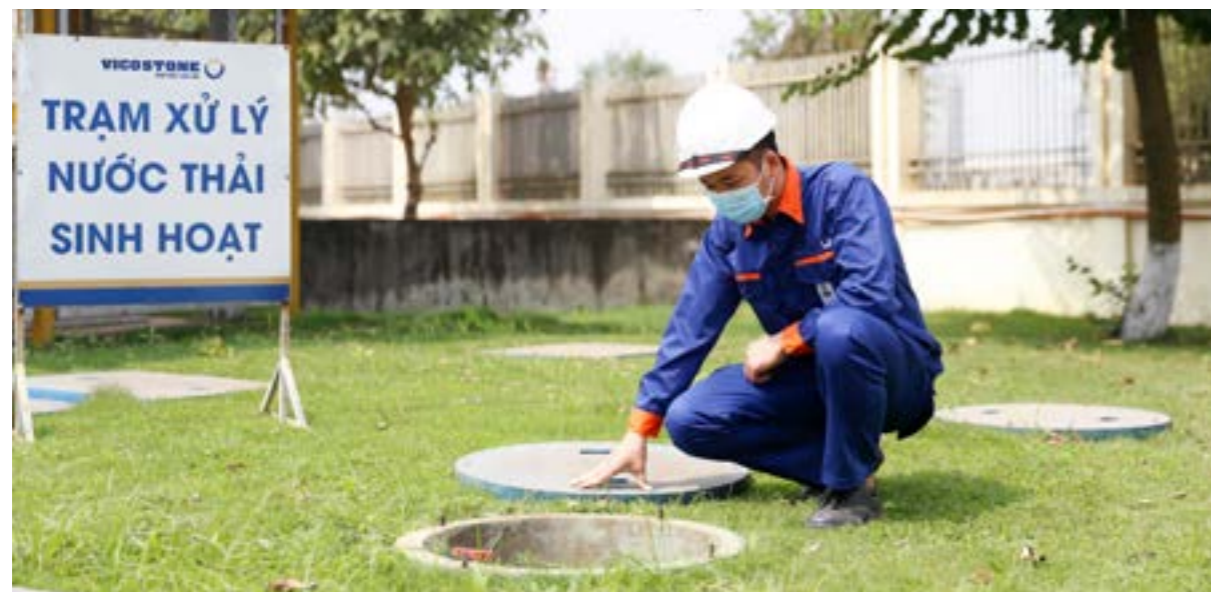
Trạm xử lý nước thải sinh hoạt
