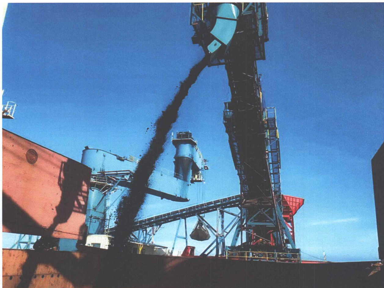
(Thiết bị chuyên dụng tiến hành rót than lên tàu tại cảng xếp Muara Berau, Indonesia)
