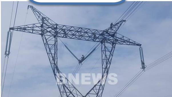
Đường dây 500kV Nhiệt Điện Vân Phong – Nhiệt Điện Vĩnh Tân
