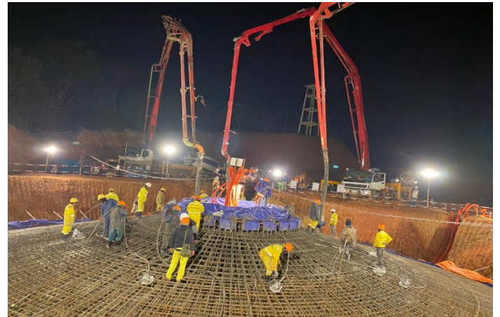
Đổ móng bê tông – Điện gió Phong Nguyên
