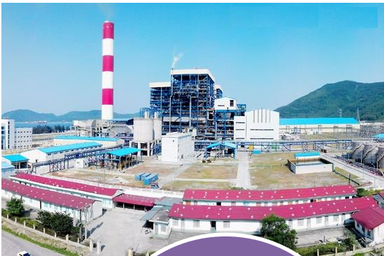
Nhà máy Nhiệt điện Vũng Áng 1
