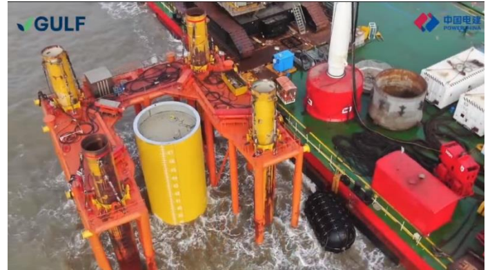
Lắp cột trụ đầu tiên ngoài biển – Điện gió Bình Đại
