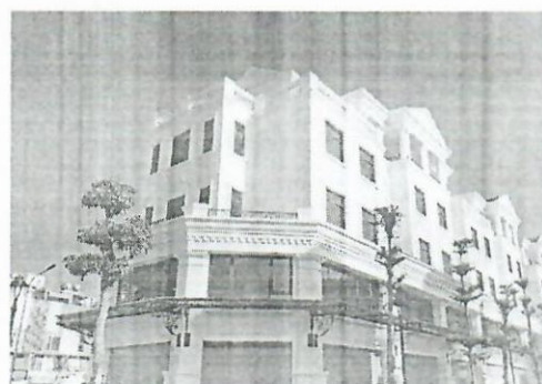
Hình ảnh 10: Sản phẩm DAA lắp đặt tại Vinhomes Cầu Rào 2 Hải Phòng
