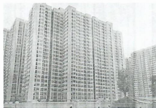
Hình ảnh 12: Sản phẩm DAA lắp đặt tại Vinhomes Ocean Park
