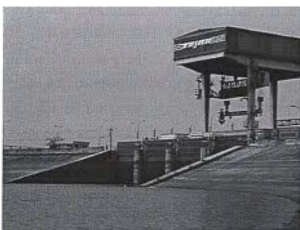
**Thủy điện Trị An – Đồng Nai** : Thi công toàn bộ tuyến áp lực và ½ cửa nhận nước (1984-1987). Đập chính là đập đất đá hỗn hợp có chiều dài 420m, đập tràn là đập bê tông trọng lực, chiều dài 150m với 8 khoang tràn x 15m. Nhiệm vụ chính của công trình là phát điện công suất lắp máy 400MW, điện lượng trung bình hàng năm 1,7 tỷ KWH, cải thiện lưu lượng nước sông Đồng Nai vào mùa khô.
