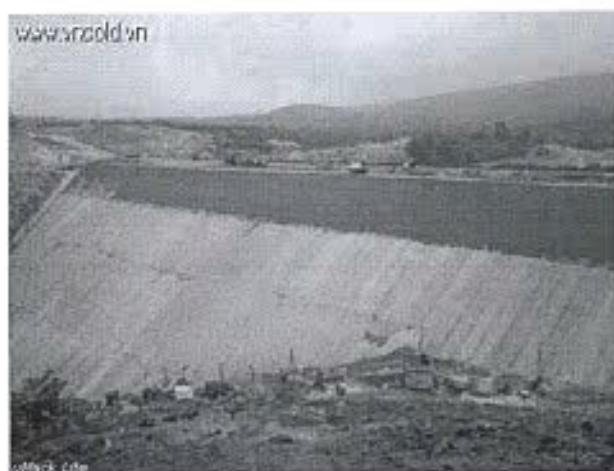
**Thủy điện A Vương – Quảng Nam :** Thi công đập chính và tràn xả lũ (2005-2008). Công trình phát điện với công suất lắp máy 210 MW và điện lượng trung bình hàng năm 815 triệu KWH. Đập chính là đập bê tông đầm lăn RCC, đập thi công theo công nghệ RCC đầu tiên của nước ta với khối lượng khoảng 400.000 m<sup>3</sup> bê tông.
