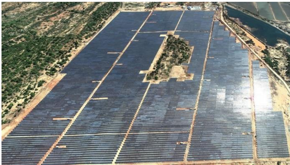
Dự án điện mặt trời Thuận Nam 19
