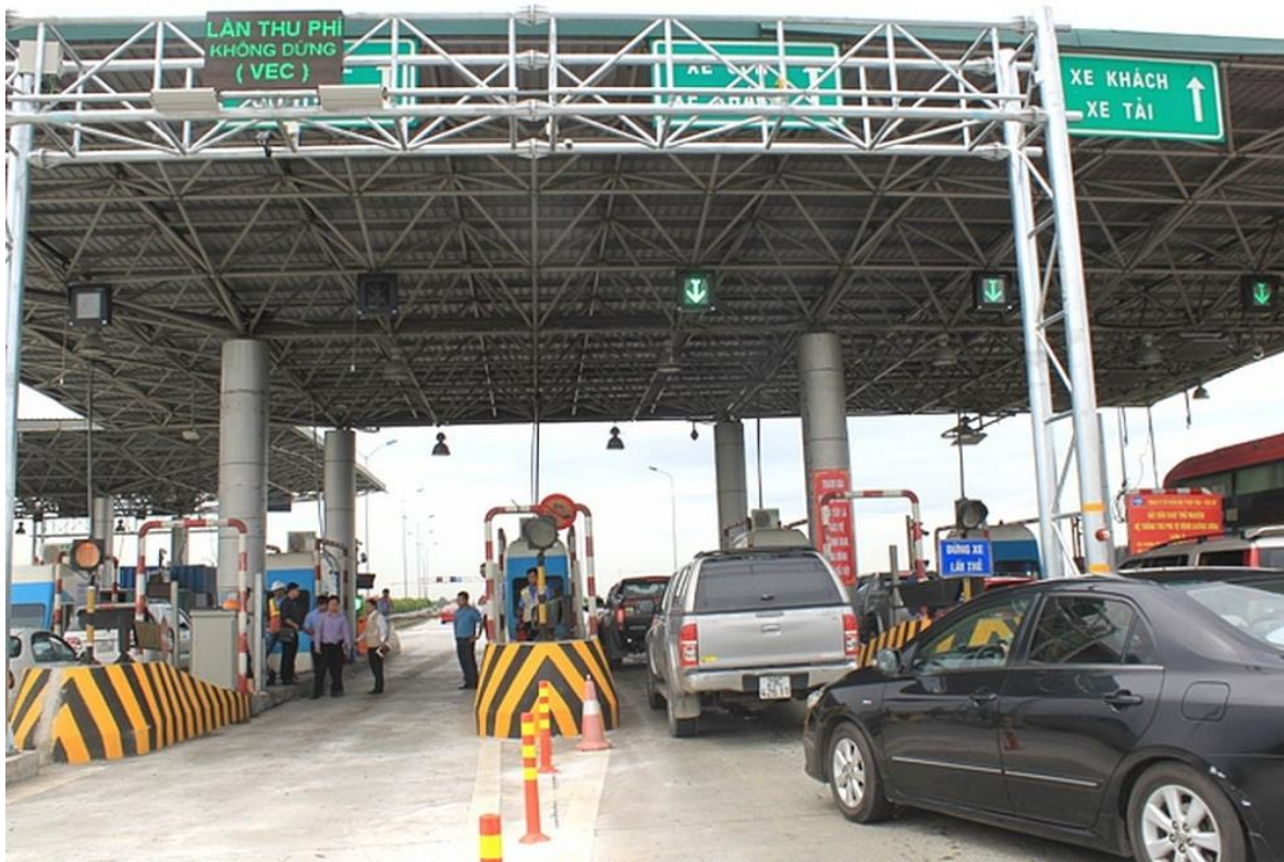
Làn thu phí ETC tại Trạm Pháp Vân – Cầu Giẽ - Ninh Bình
