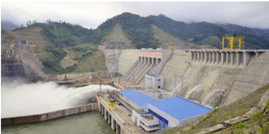
Thủy điện Lai Châu (khánh thành ngày 20/12/2016)
