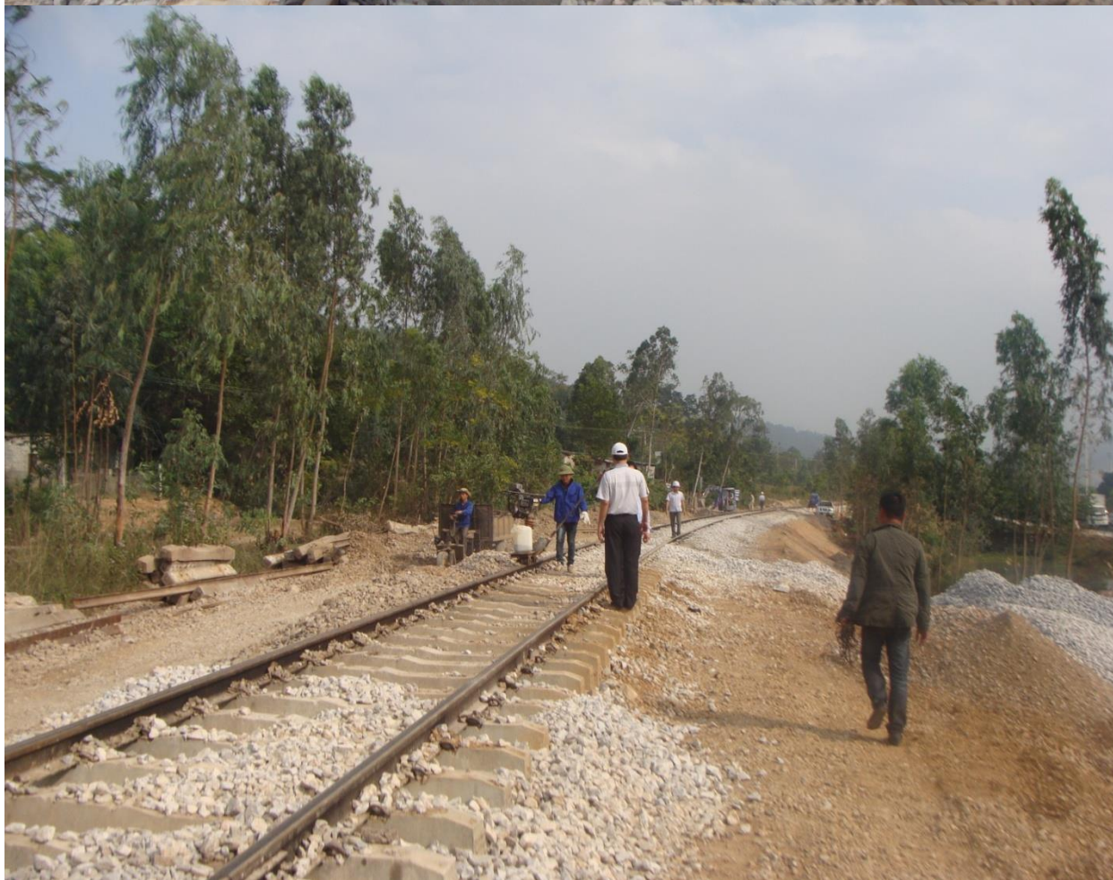
* Thi công công trình đường sắt vào mỏ than Quảng Ninh 2016:
