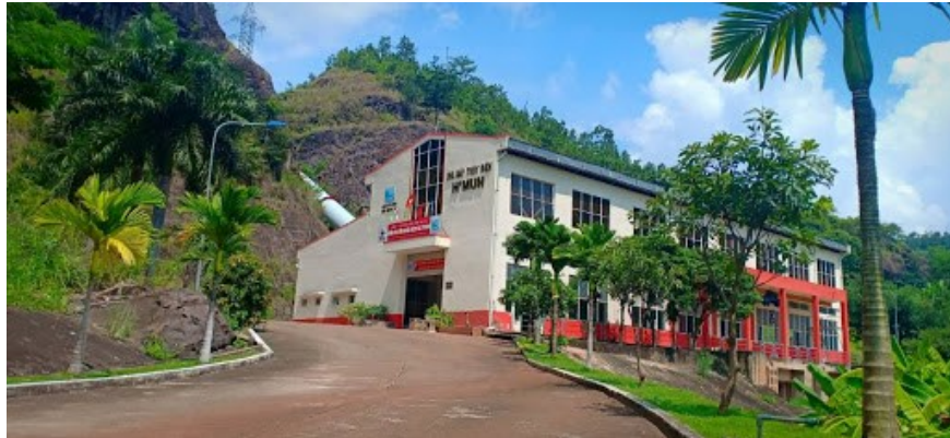
Hình 7: Dự án thủy điện TTC H'mun
