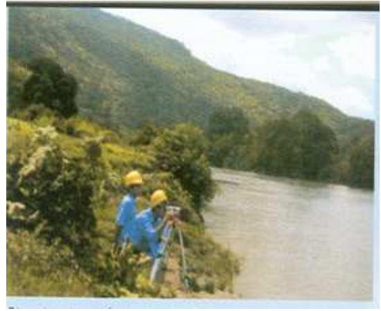
Khảo sát địa hình Công trình thủy điện Cổ Bi
