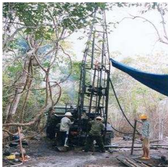
Máy khoan tự hành khảo sát địa chất Công trình Thủy điện Ea Krông H' năng
