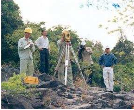
Khảo sát địa hình Công trình thủy điện Ae Krông H'nh
