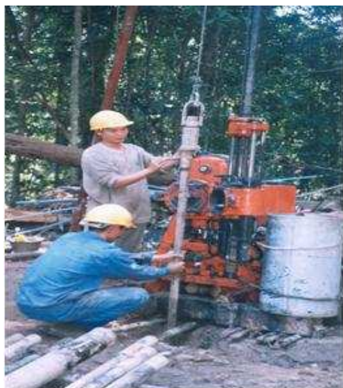
Khoan máy XY – 1A Thủy điện Ea Krông Rou
