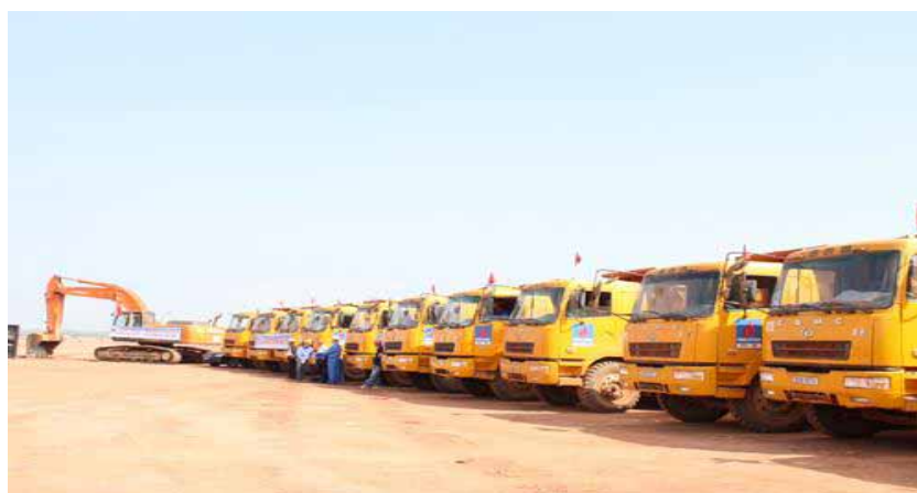
Trên công trường Nhà máy lọc hóa Dầu Nghi Sơn – Thanh Hóa
