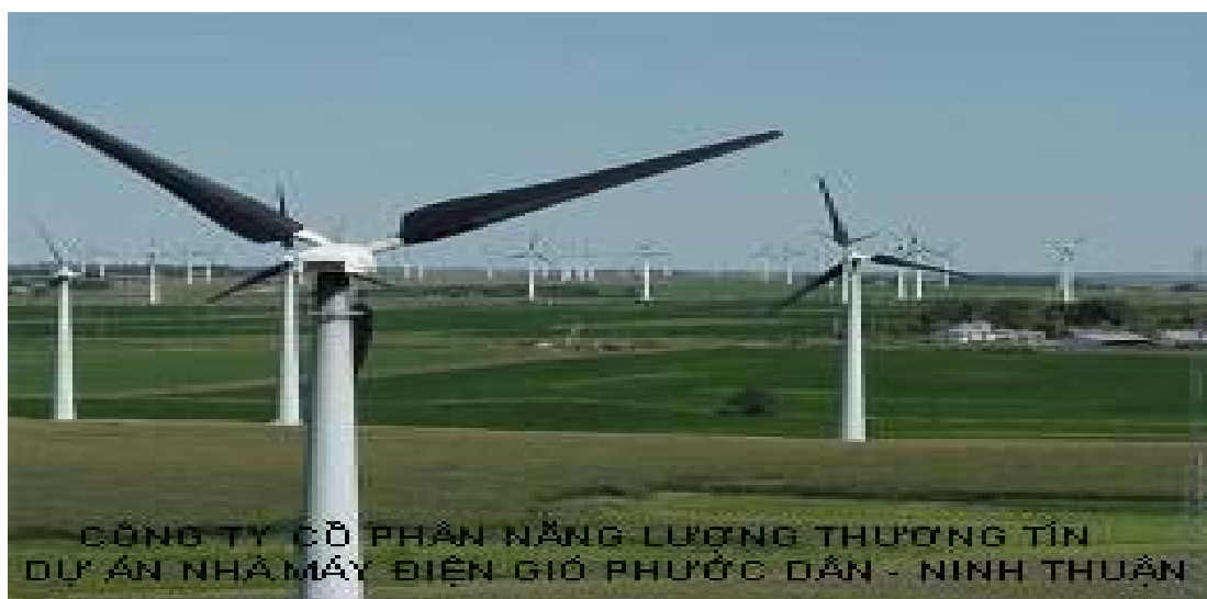
Hình 16: Dự án Nhà máy Điện gió Phước Dân
