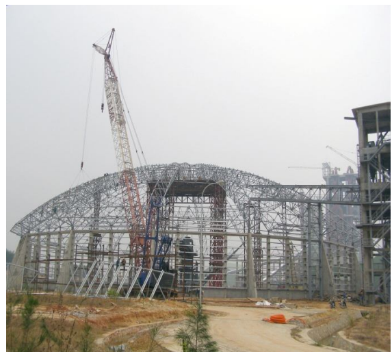
Lắp đặt kết cấu kho tròn nhà máy xi măng Thăng Long
