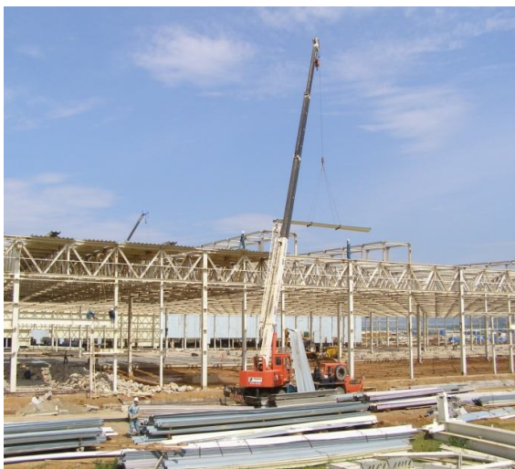
Lắp đặt kết cấu thép nhà máy ô tô VEAM thanh hóa
