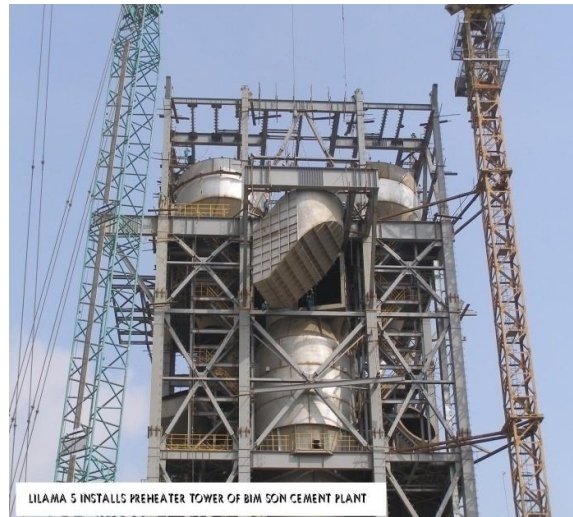
Lắp đặt kết cấu thép tháp trao đổi nhiệt dự án dây chuyền mời NMXM Bỉm Sơn
