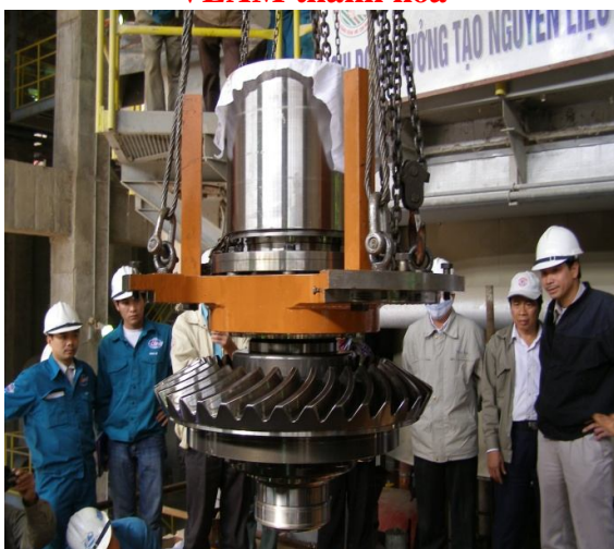
Sửa chữa thiết bị nhà máy xi măng Bỉm Sơn
