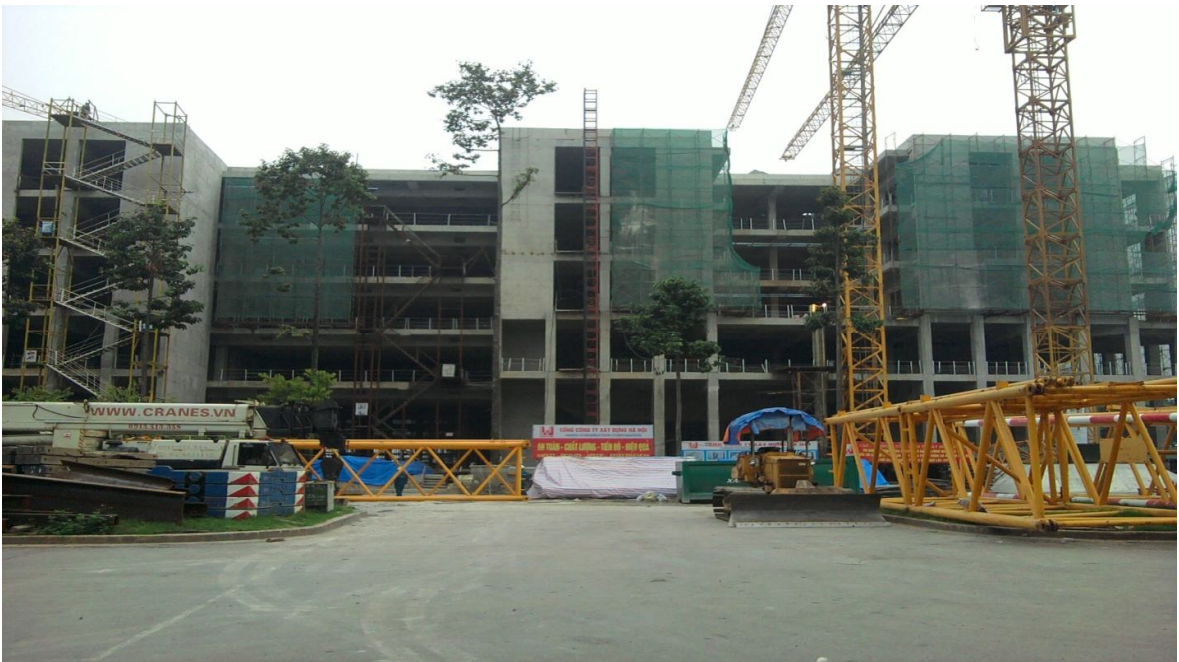
Cung cấp và lắp đặt hệ thống điện công trình Nhà Quốc Hội
