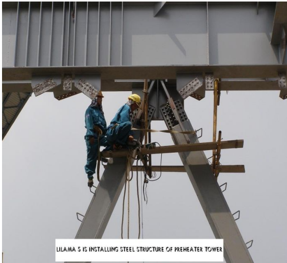
Lắp đặt kết cấu thép tháp trao đổi nhiệt dự án dây chuyền mời NMXM Bỉm Sơn
