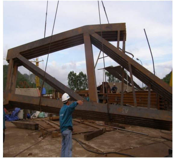
Chế tạo dầm thép dự án bảo tàng Hà Nội
