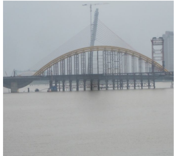
Chế tạo và lắp đặt dầm thép cầu rồng Đà Nẵng
