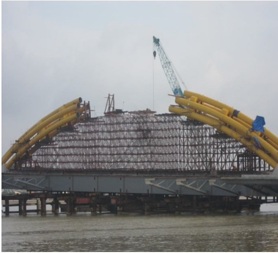
Chế tạo và lắp đặt dầm thép cầu rồng Đà Nẵng
