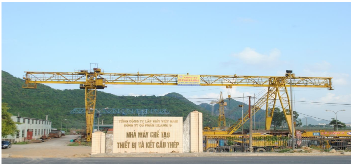
Nhà máy chế tạo thiết bị và kết cấu thép Công ty
