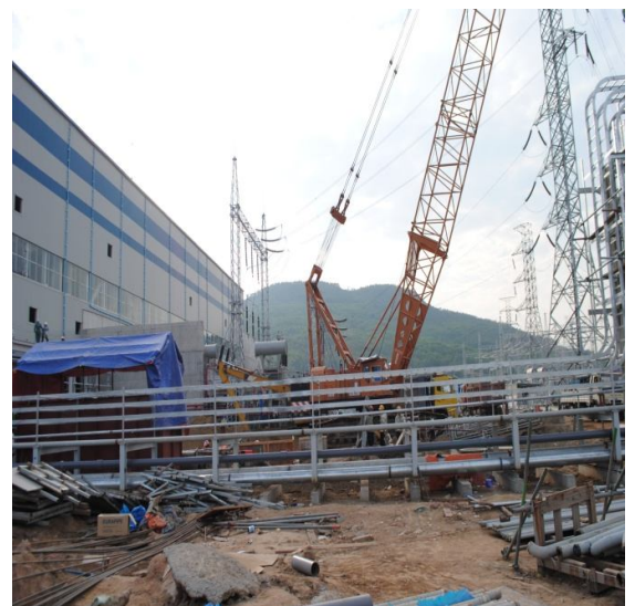
Lắp đặt thiết bị và đường ống công nghệ NM nhiệt điện Nghi Sơn
