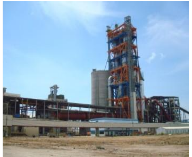
Nhà máy xi măng Cẩm Phả
