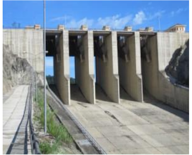
Đập tràn xả lũ Cửa Đập Thanh Hóa
