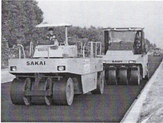
Thi công DA Đường Vành đai phía tây Đà Nẵng
