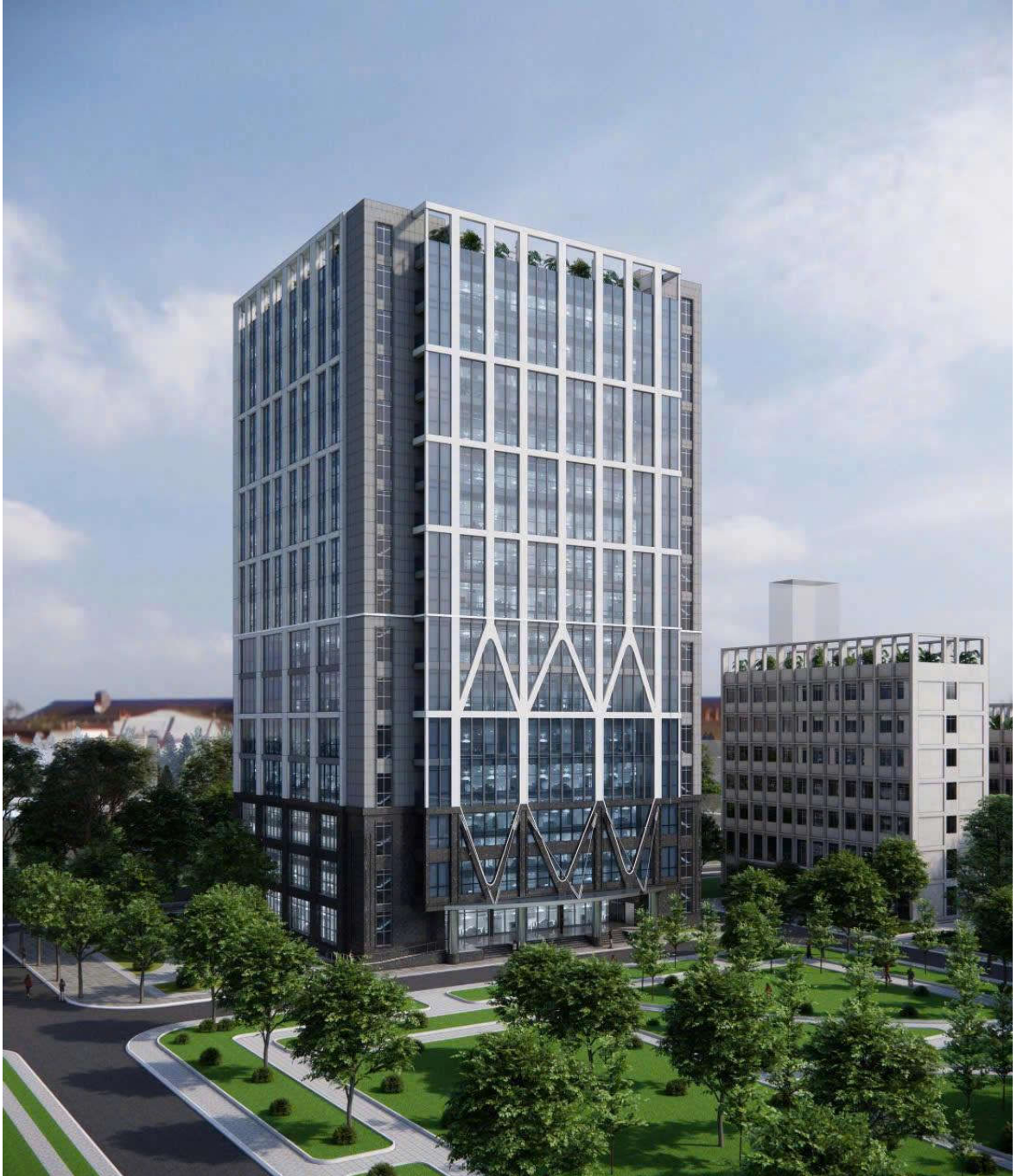
Công trình Nhà S8 Học viện Kỹ thuật Quân sự do Công ty cổ phần Đầu tư và xây lắp Thành An 665 thi công
