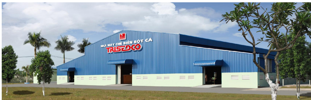
NHÀ MÁY CHẾ BIẾN BỘT CÁ TRISEDCO
