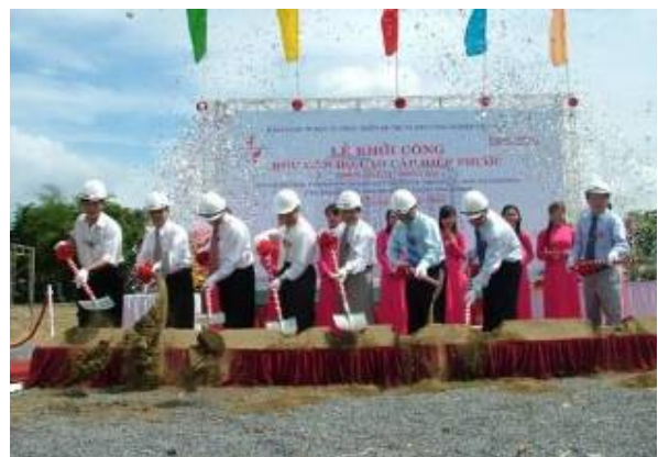
Lễ khởi công xây dựng Khu chung cư cao cấp Hiệp Phước
