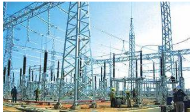
Thi công lắp đặt trạm điện Tuy Hạ
