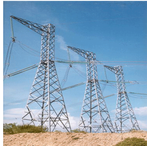
ĐZ 500Kv PlâyKu - Phú Lâm - cung đoạn VNECO thi công
