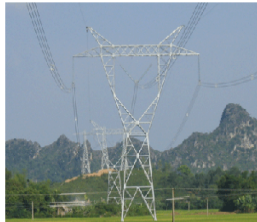
ĐZ 500Kv Thường Tin - Nho Quang - cung đoạn VNECO thi công
