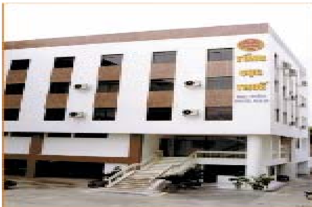
Công trình xây dựng Văn phòng Tổng cục Thuế phía Nam tại TP.HCM
