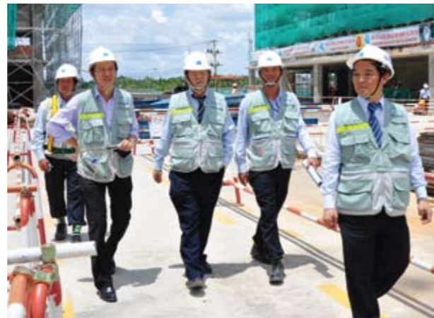
Ông Lê Viết Hải hướng dẫn các đại biểu của UOA - một đối tác chiến lược và cổ đông tiềm năng tham quan công trình Hòa Bình thi công
