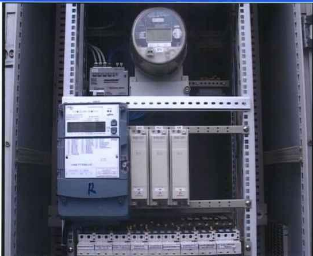
Thị điểm triển khai lắp đặt công tơ điện tử và ứng dụng hệ thống thu thập dữ liệu từ xa
