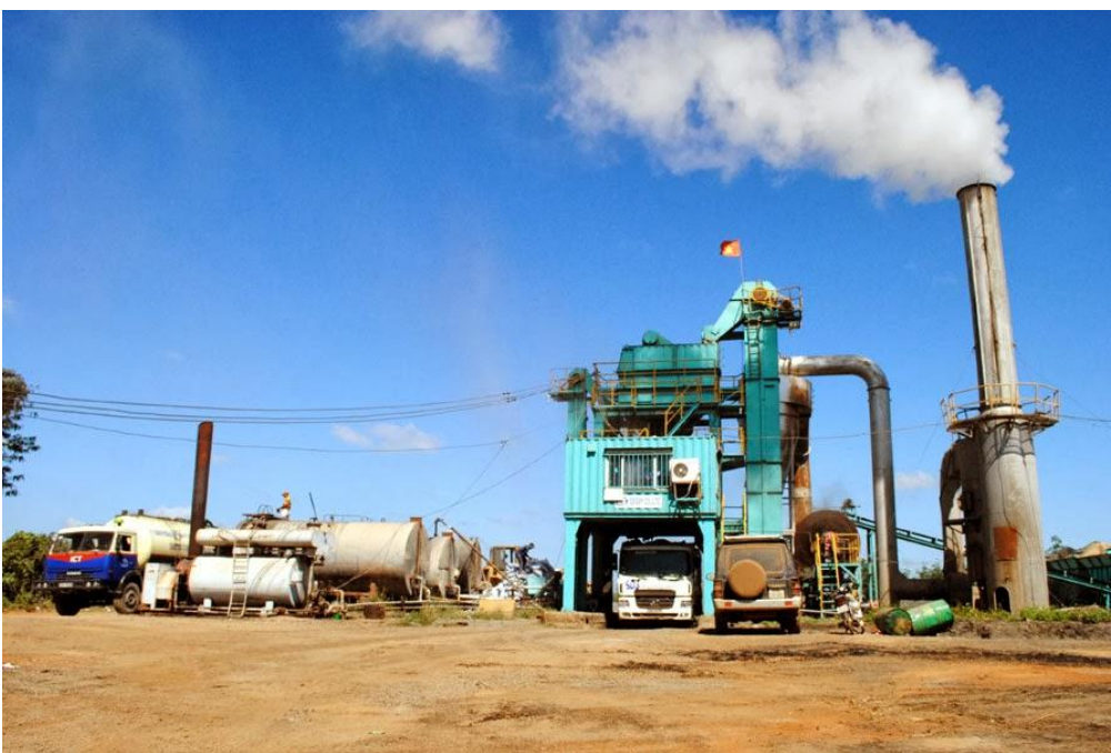
Công ty lắp đặt các máy trộn bê tông trong phạm vi dự án
