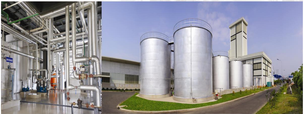
Hệ thống bồn chứa và trang thiết bị hiện đại của nhà máy distilling dầu
