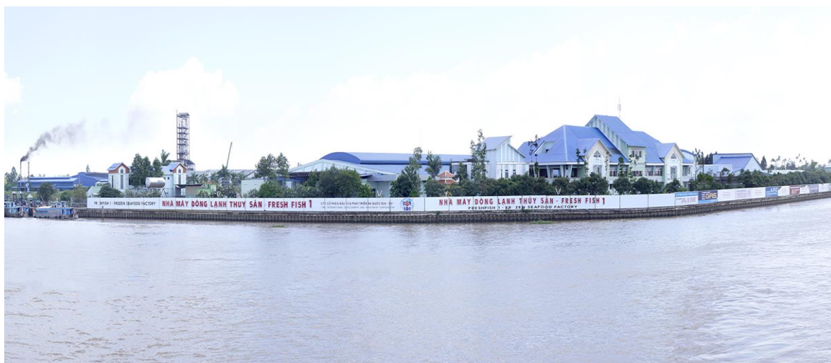
TOÀN CẢNH CỤM CÔNG NGHIỆP VÀM CỐNG NHÌN TỪ SÔNG
