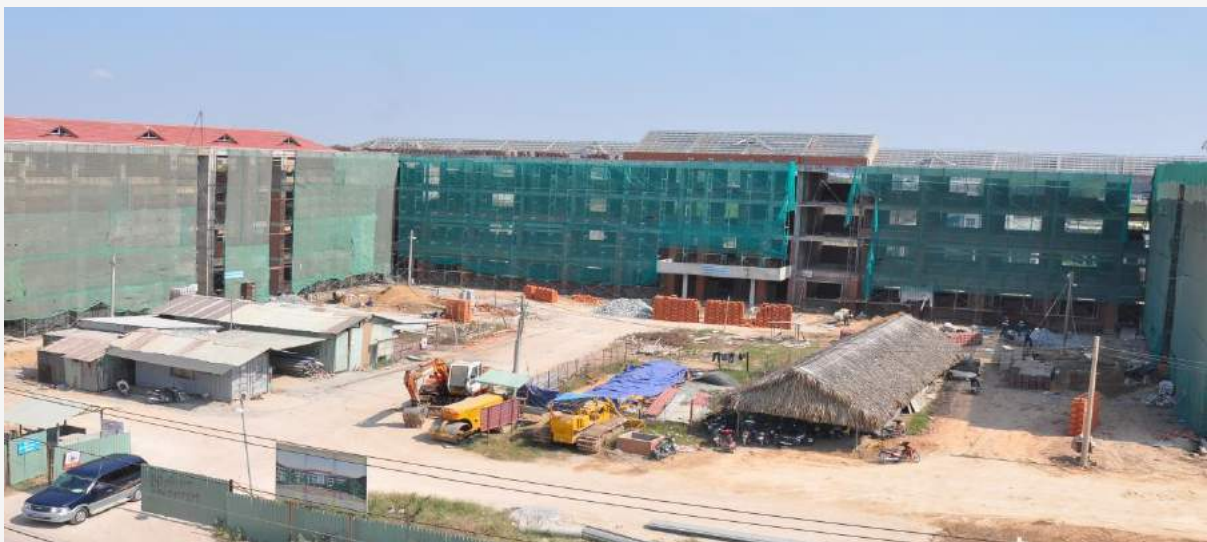
TRƯỜNG THCS THUẬN GIAO_C32 ĐANG XÂY DỰNG
