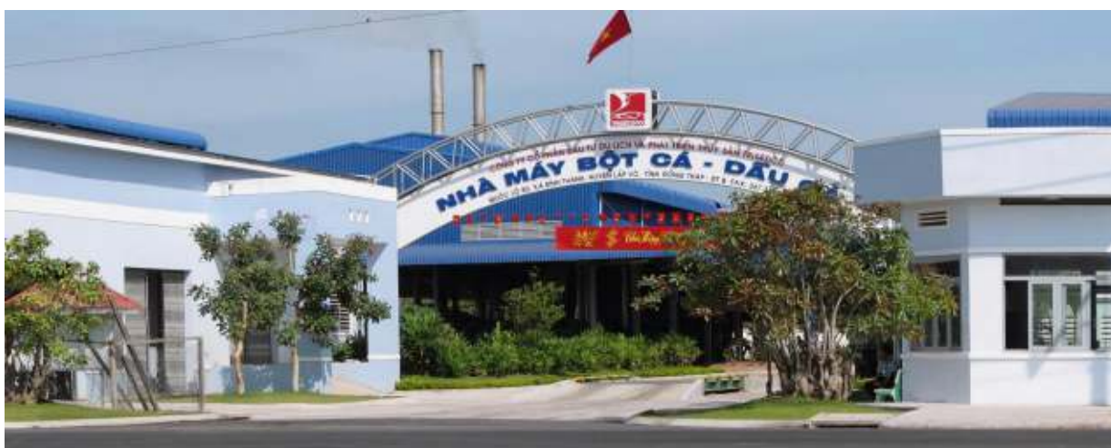
Nhà máy chế biến Bột cá - Dầu cá
