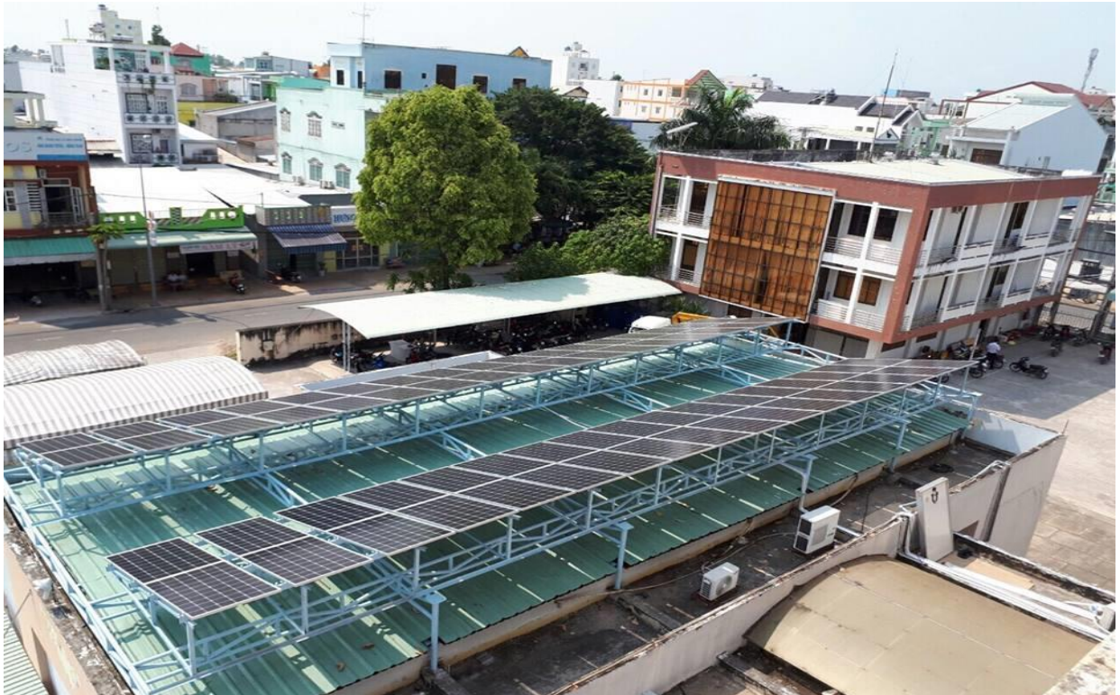
Hệ thống điện năng lượng mặt trời 98kWp tại Công ty Điện Lực Đồng Tháp
