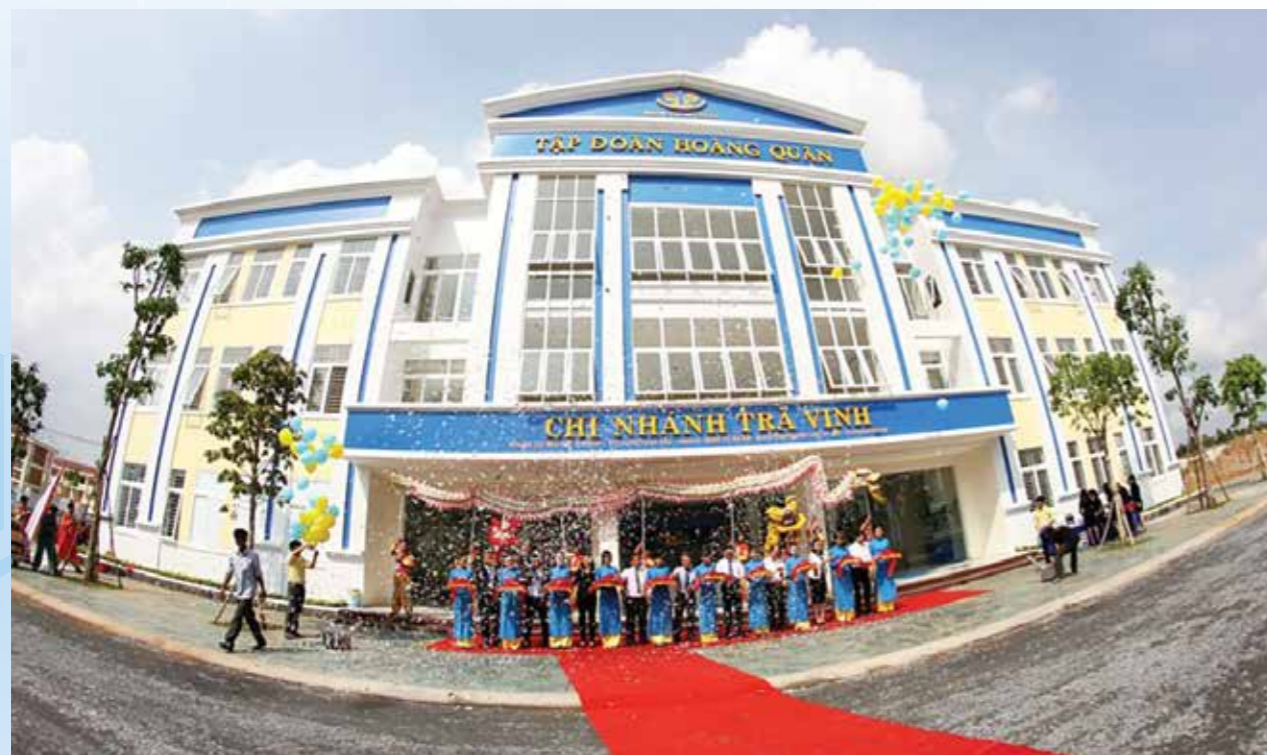
Toàn cảnh Nhà điều hành Khu đô thị mới Trà Vinh
