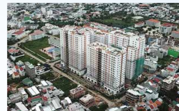
Dự án Paradise Plaza
