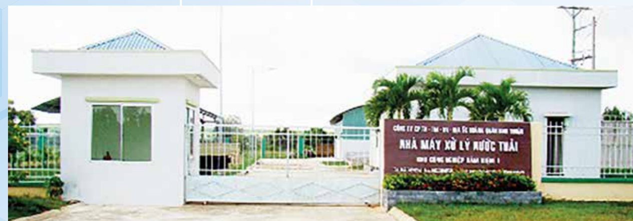
Nhà máy xử lý nước thải KCN Hàm Kiệm I
