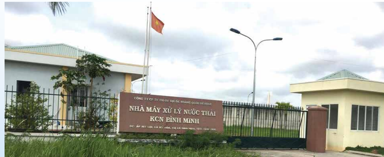
Nhà máy xử lý nước thải KCN Bình Minh
