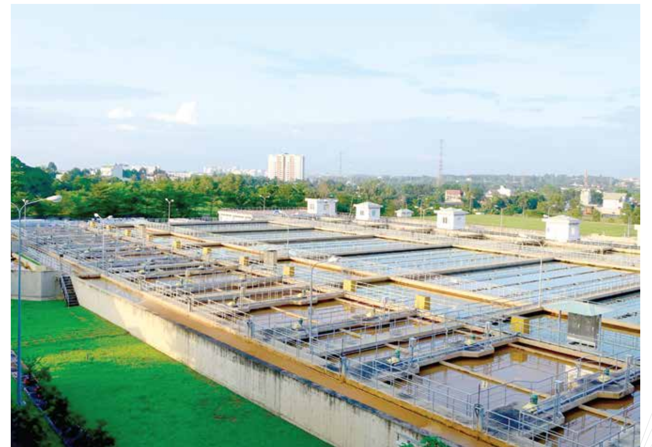
Nhà máy nước B.O.O Thủ Đức
