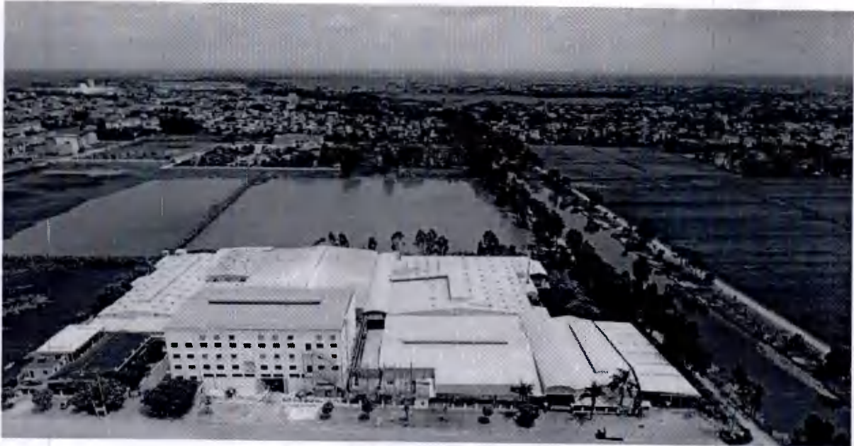
Nhà máy 1A, 1B
