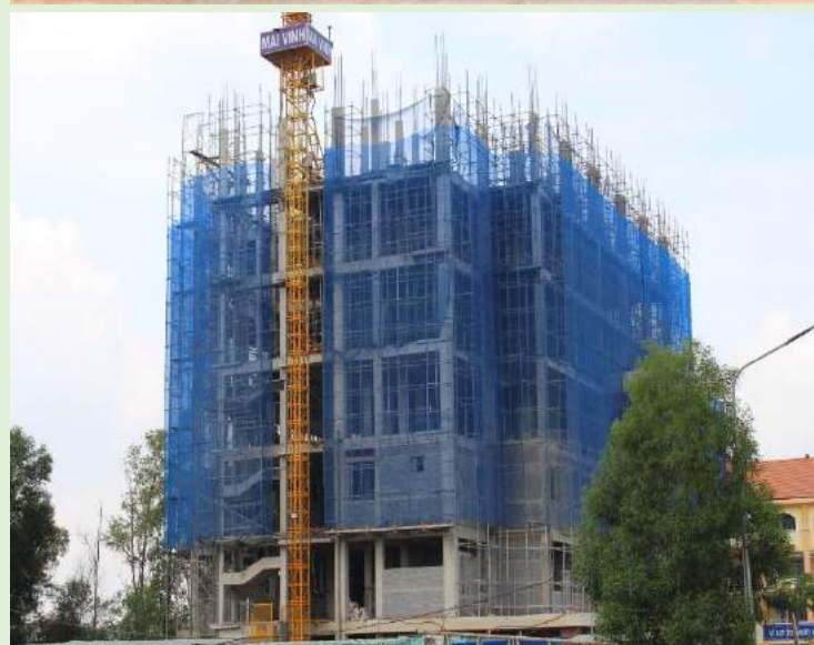
THI CÔNG CÔNG TRÌNH TRƯỜNG HỌC
