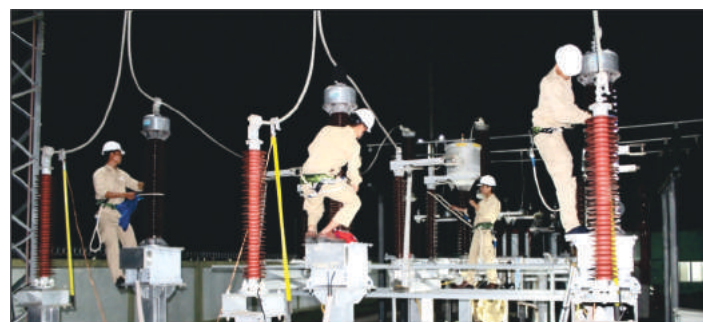
Các cá nhân sử dụng đầy đủ dây an toàn khi làm việc trên cao.
