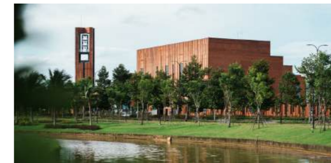
EMASI Plus Waterpoint - Bến Lức, Long An
