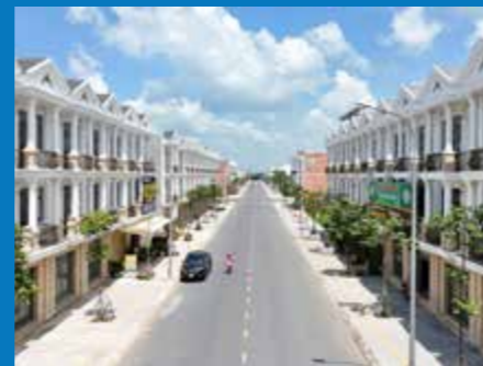
DỰ ÁN ĐƯỜNG D7
