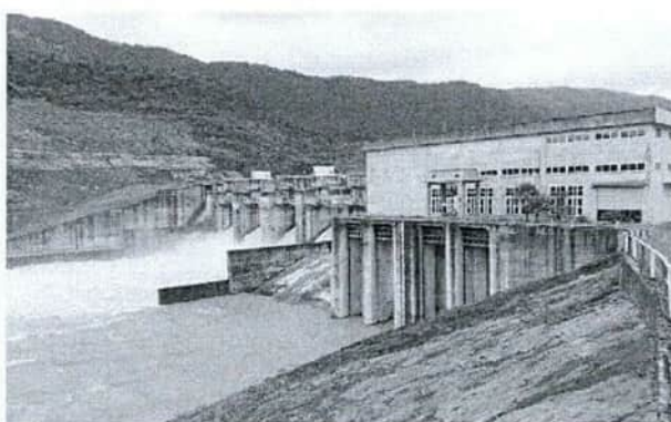
Dự án thủy điện Sông Bung 4A
