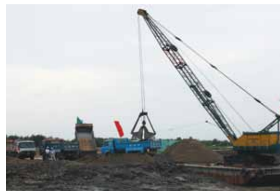
Công trình thi công san lấp mặt bằng của Cảng quốc tế Long An
