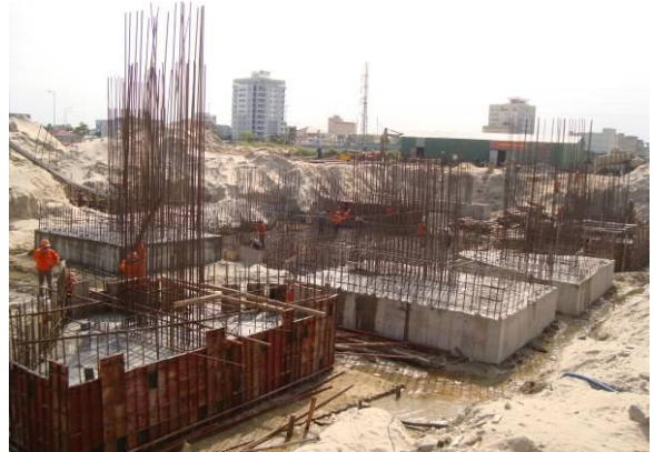
Thi công đài móng
