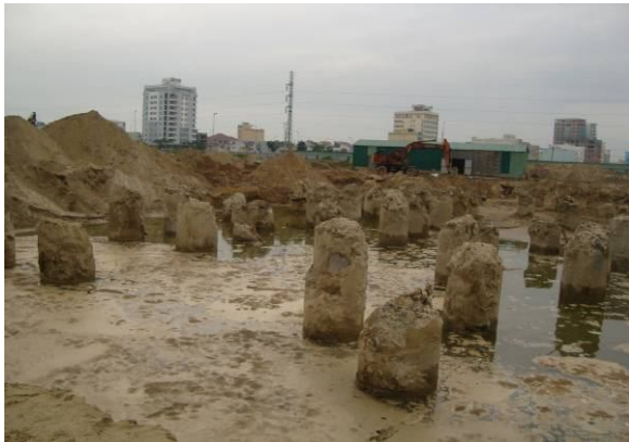
Thi công đập đầu cọc
