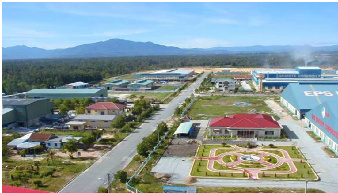
TOÀN CẢNH KHU CÔNG NGHIỆP PHÚ BÀI - HƯƠNG THỦY - TỈNH THỪA THIÊN HUẾ
