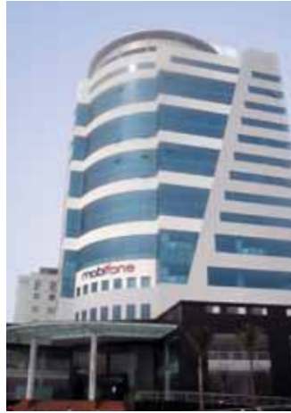
Tòa nhà MobiFone - Khu VP1, Phường Yên Hòa, Quận Cầu Giấy, Thành phố Hà Nội, Việt Nam hiện là trụ sở của MobiFone
