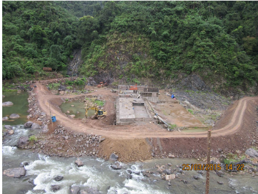
Toàn cảnh đập dâng – đập tràn Nhà máy thủy điện Đa Krông 1
