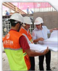
Descon hợp tác với Socon thi công dự án khu căn hộ cao cấp D-Vela 30.10.2017
