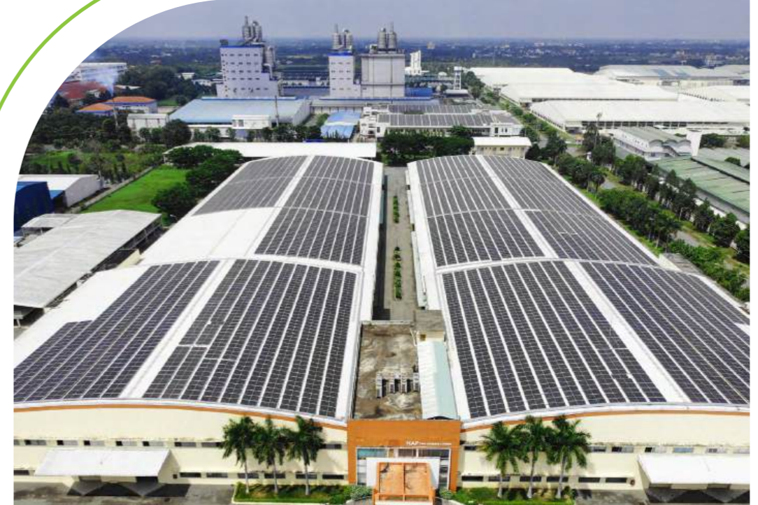
Hệ thống điện mặt trời áp mái Kapvina
