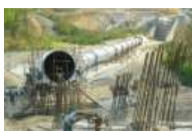
Công trình thủy điện Đại Ninh
