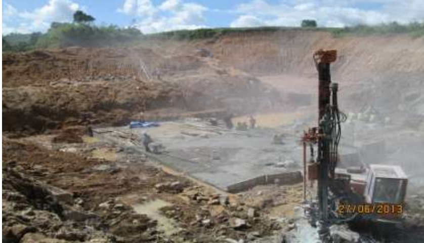
Hình ảnh công trường Dự án Thủy điện Hà Tây
