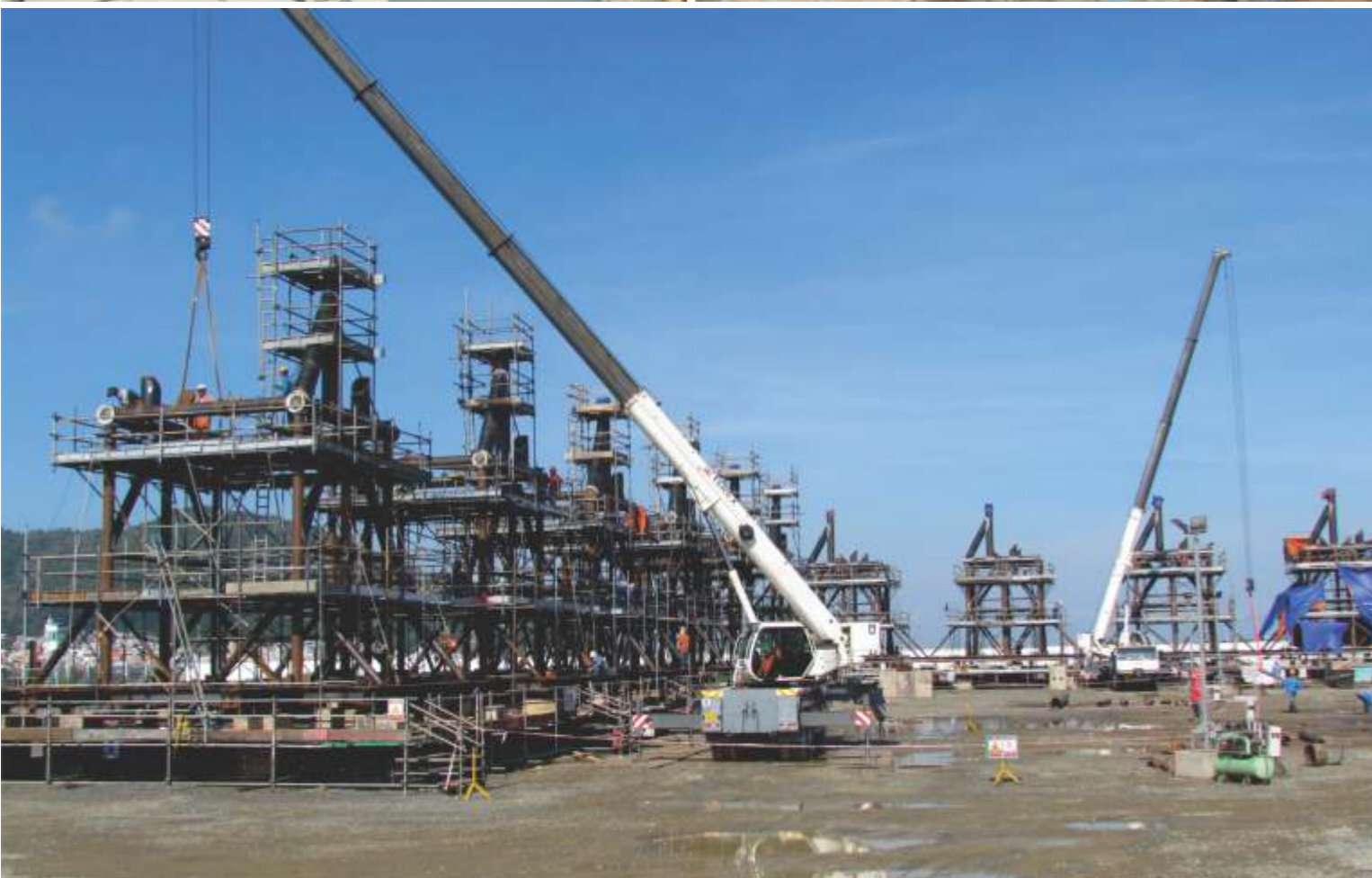
Công nhân Công ty thi công chế tạo và lắp đặt công trình cơ khí dầu khí tại công trường
