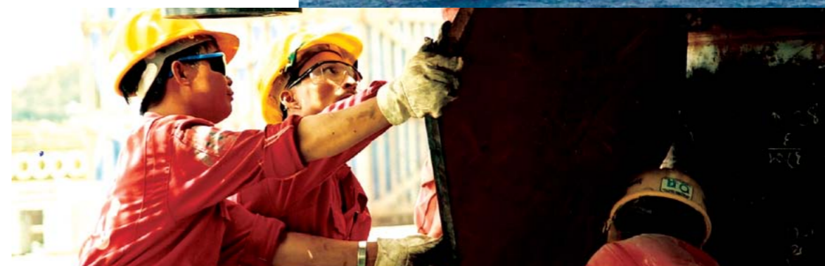
Dịch vụ vận chuyển, lắp đặt, đầu nổi, chạy thử, vận hành, sửa chữa và bảo dưỡng các công trình dầu khí
